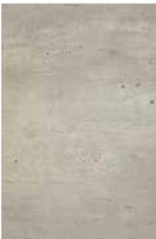
972 Beton 972 Concrete 972 Hormigón 972 Béton
